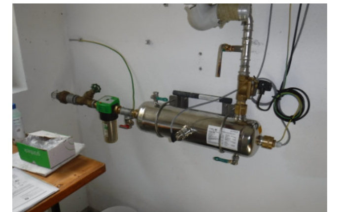
Aufbereitungs-Anlage im Keller der Hütte
