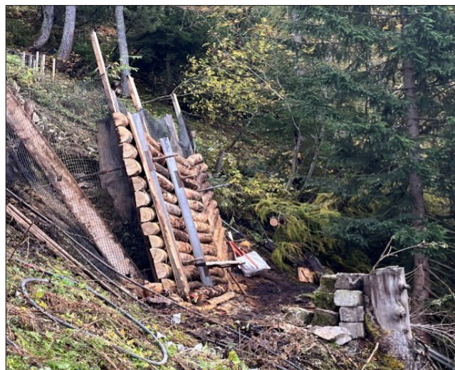
Einrichtung der Holzankerwand
