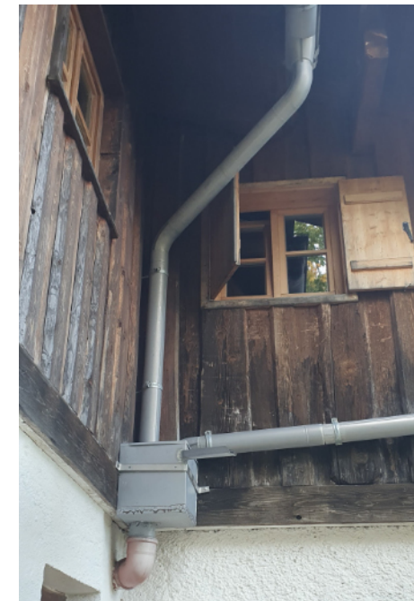
Dachwasser-Ableitung an der Hütte
