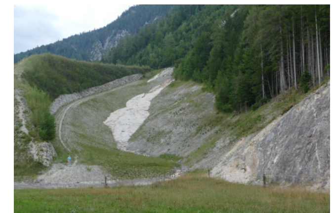
Rainlähne: Lawinenschutzdamm, helle Muraufschüttungen
